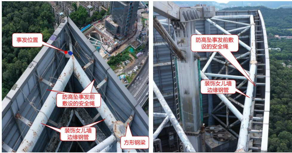
图 10 百仕达大厦楼顶勘查图 2
