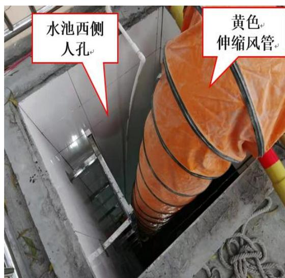
图 14 手提式抽送风机送风管位置勘查图
