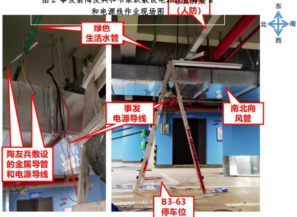
图3 事发前陶友兵和韦家跃敷设电源线金属导管和电源线作业现场图
